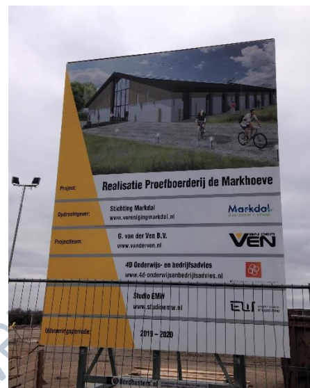
Figuur 5: Werkzaamheden aan Markhoeve
